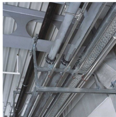
O型管卡固定管道应用
