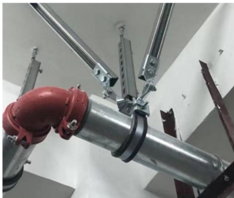
U型管卡固定管道应用
